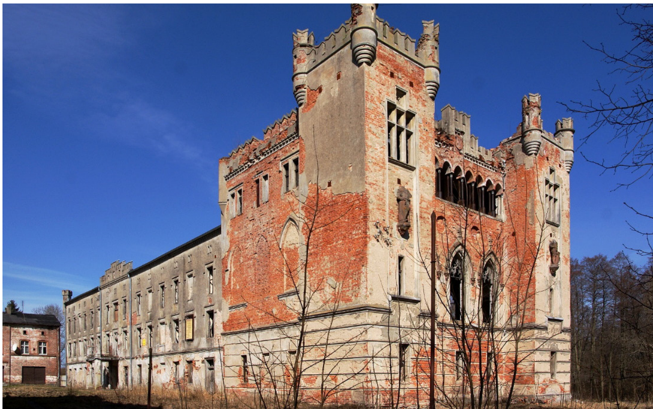
il. 3. Kozia Góra. Widok na dobudowany masyw wieżowy od strony wsch. oraz drugie piętro głównego budynku. Fot. z lat 90. XX w.
